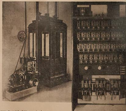
grupo de control eléctrico y partes de tracción tipo velocidad. Dos ejemplares que miden la proporción de una pequeña muestra el primer ascensor controlado por ADAMOLI Y CIA. LTDA. y el de las unidades que se fabrican actualmente de acuerdo a las técnicas más avanzadas de la industria.
